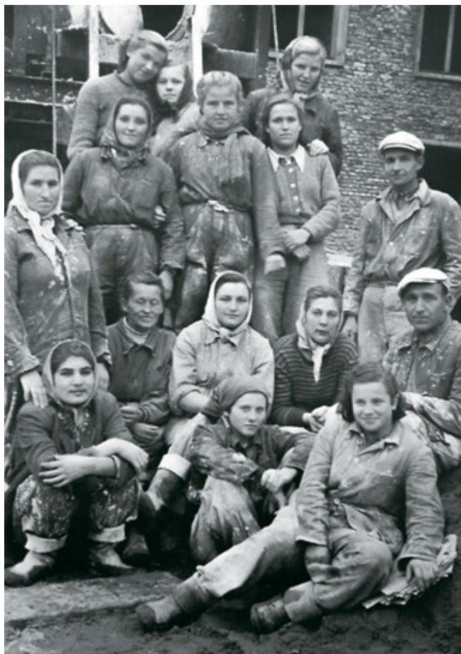
Brygada tynkarek z instruktorami na budowie osiedla B-2, 1952 r.
