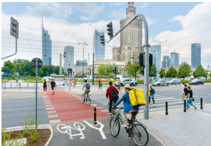
Nowe przejście naziemne przez ul. Marszałkowską w Warszawie.
